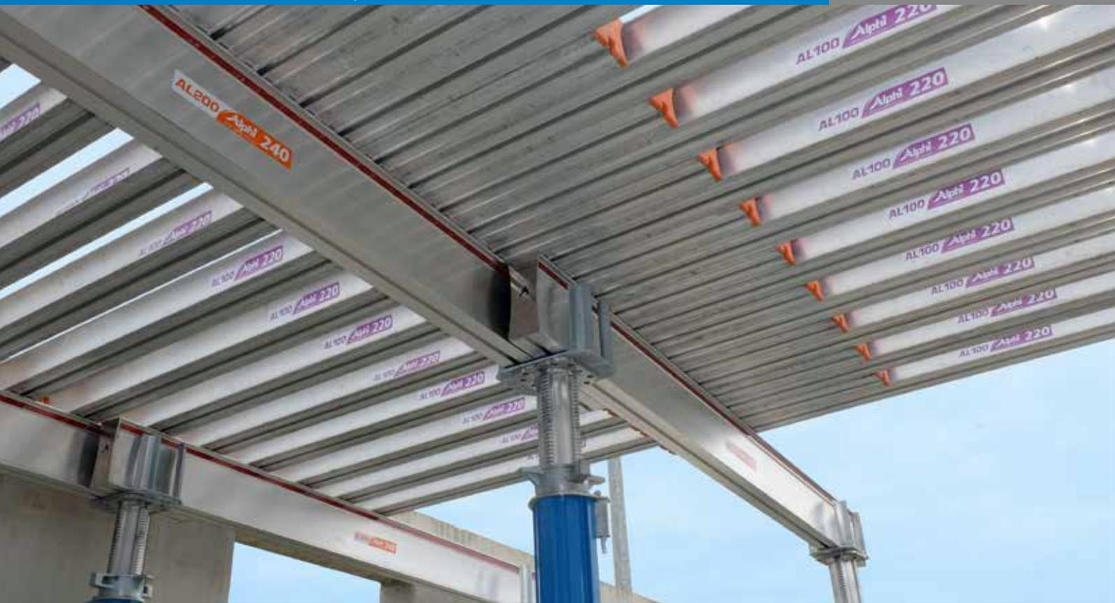
Les deux gammes de poutrelles, bois et aluminium, répondent aux différentes configurations de chantiers. Les poutrelles anti-renversement permettent d'éviter les chutes de hauteur.
