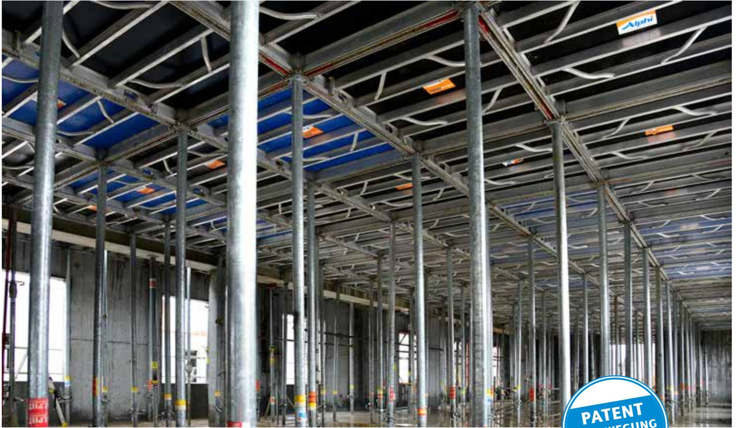
**MaxUp** ist ein System, das eine mühelose Montage der Schalungsplatten MaxiDalle auf den Köpfen der Stützen ermöglicht.
