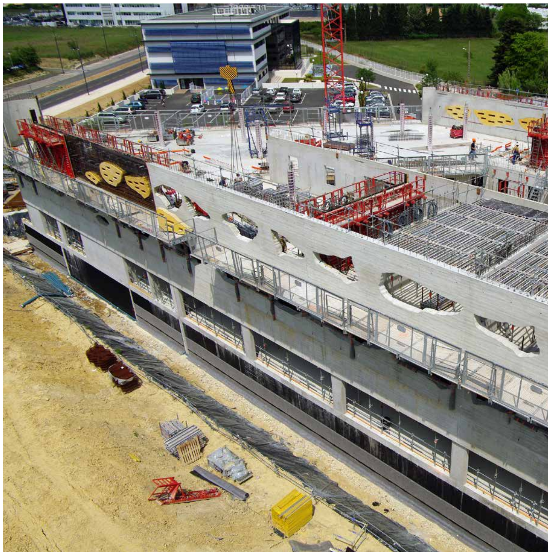
Chantier : Pôle de services Eurêka Client : GFC Construction (Groupe Bouygues) Lieu : Montpellier
