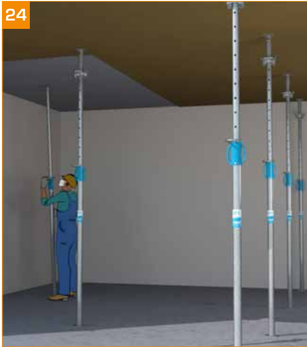
- Mise en place du premier étau de séchage en respectant un étau pour 5 m² (cas général).
