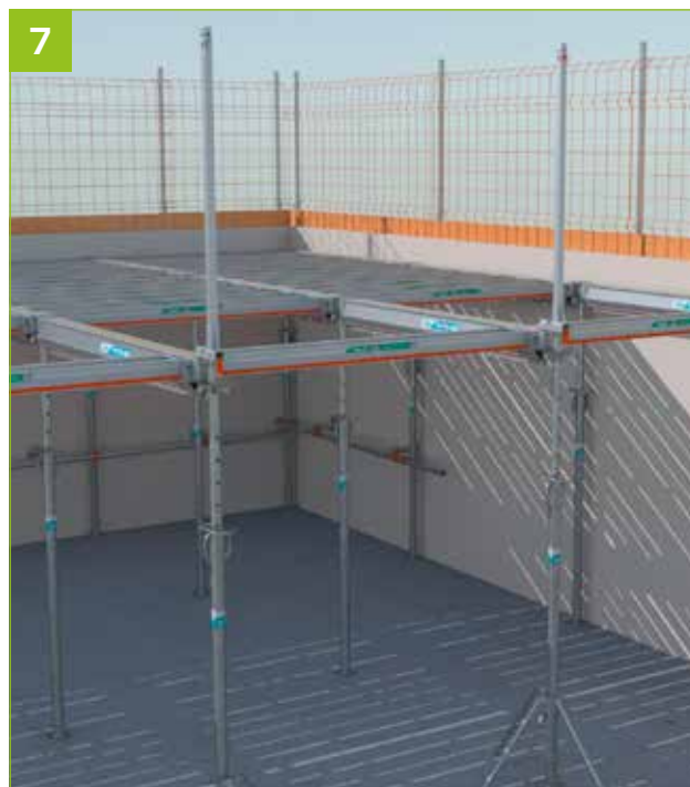
- Répéter l'opération pour l'ensemble de la trame à sécuriser.
