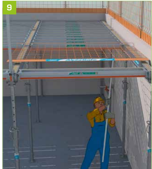
9 - L'utilisation de la perche AlphiSafe permet de rendre cette manipulation plus aisée.
