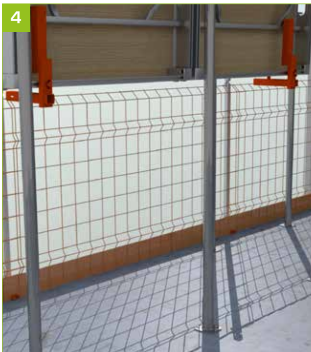
- Fixer au dos des panneaux, à leurs extrémités, 2 adaptateurs AlphiSafe pour MaxiDalle.
