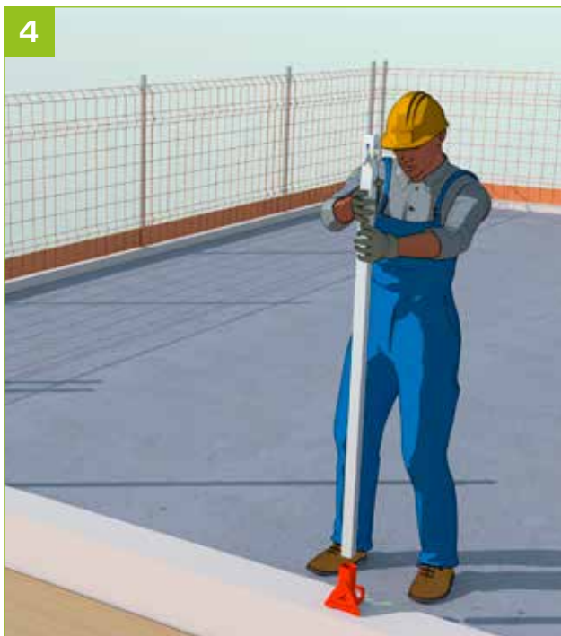
- Mettre en place les potelets.
