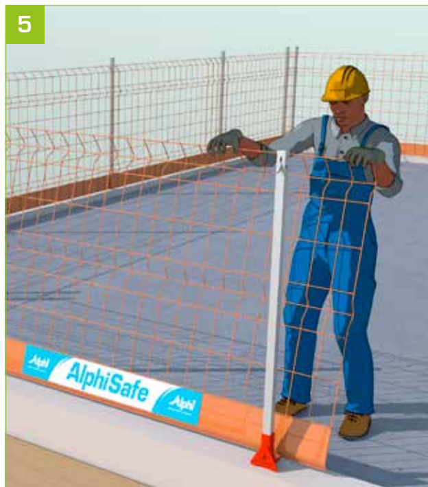
- Mettre en place la grille en s'assurant que la plithe soit bien dans l'encoche de l'adaptateur et le sommet dans l'ouverture prévue.
