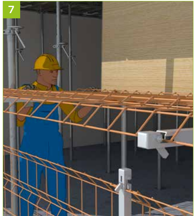
- S'assurer que la grille soit bien en place dans les emplacements en sommet et pied de potelets.
