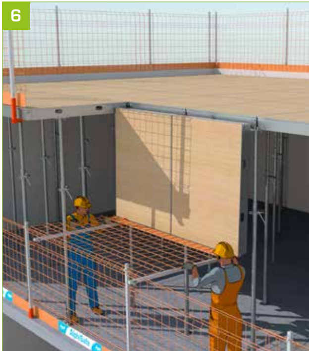
- Das AlphiSafe-Gitter anbringen.
