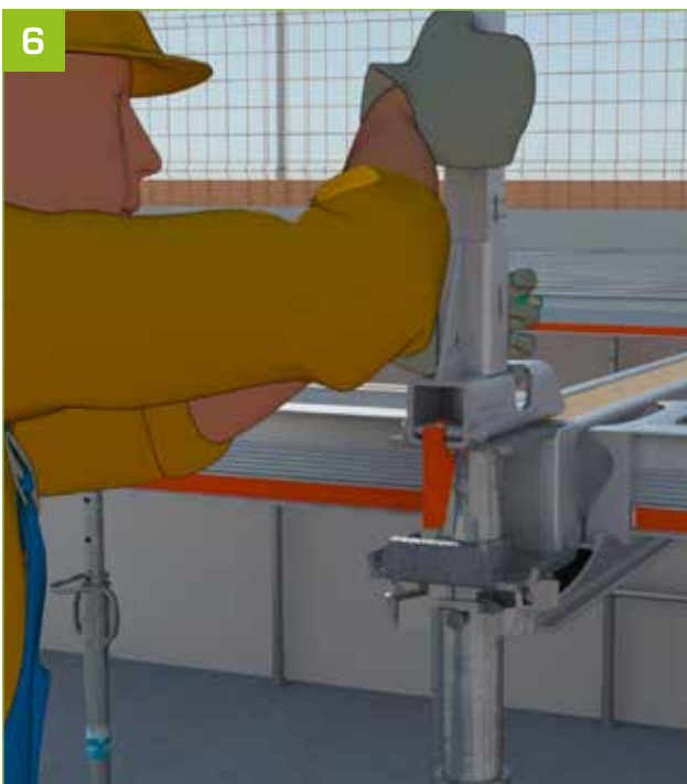
6 - Die Ausfallsicherung des Pfostens verriegelt sich automatisch auf dem Adapter.
