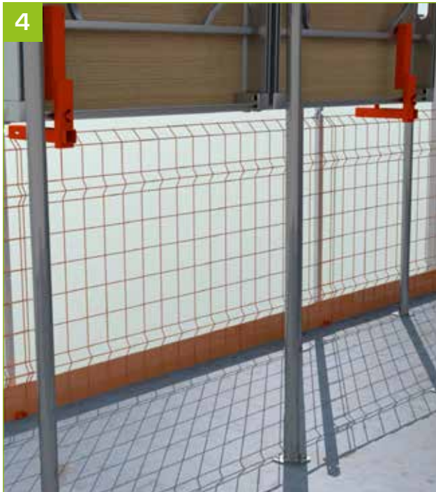
- Auf der Rückseite der Paneele jeweils am Rand 2 AlphiSafe-Adapter für MaxiDalle befestigen.
