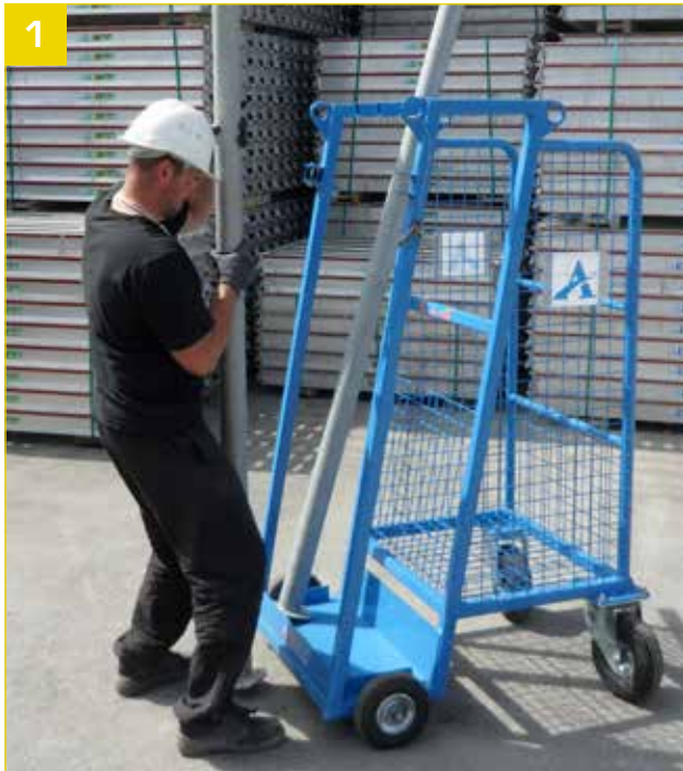
- Présentation des étais en position verticale.
