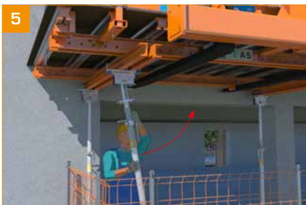
5 - Remonter le fût de l'étau. - Le verrouiller en position fermée. - Basculer l'étau en position inclinée. - Répéter l'opération pour chaque étau.
