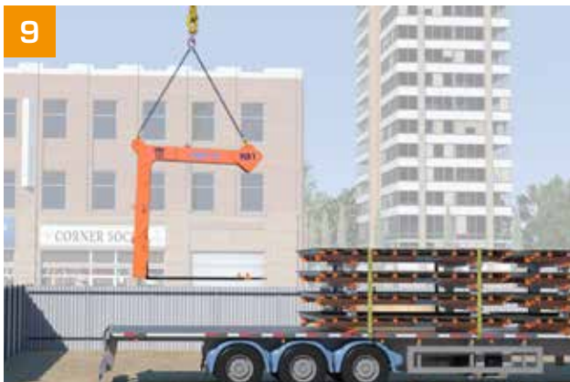
- Le palonnier se déplie automatiquement au levage.
