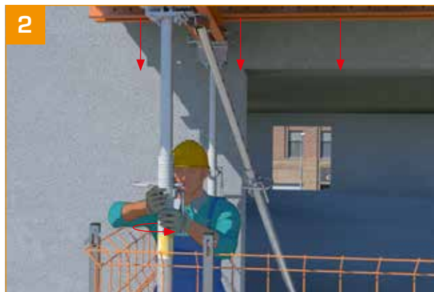
2 - Desserrer les écrous d'étais pour baisser la table de 3 à 5 cm.
